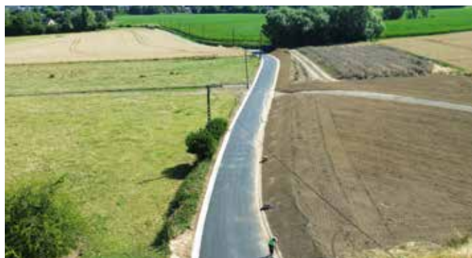
Réfection de la rue Mon Plaisir dans le cadre de la lutte contre les inondations Waudrez
