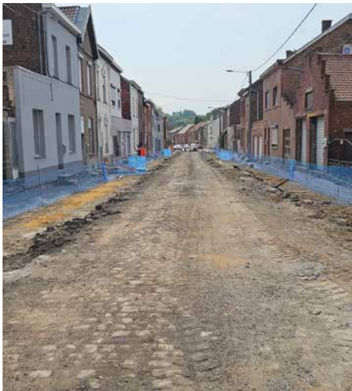
Poursuite du chantier - rue Albert 1er (phase 2) Leval
