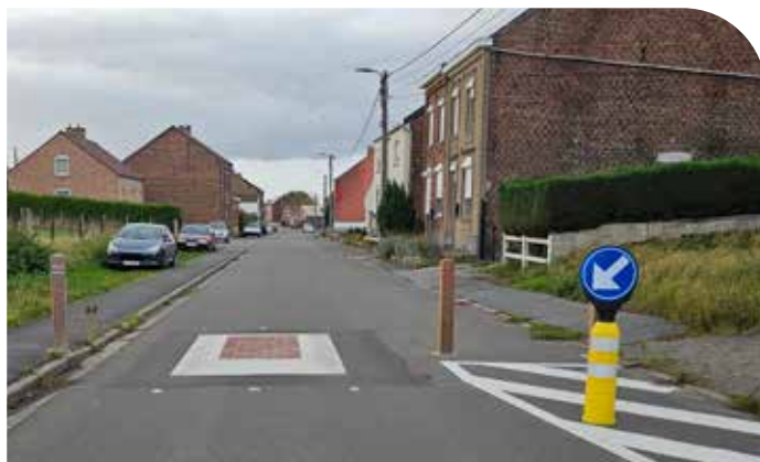
Leval - pose d'un coussin berlinois à la rue de Fontaine
