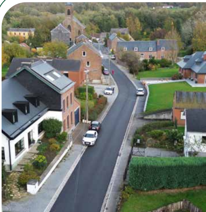
Buvrignes - réfection de la rue de la Cornette
