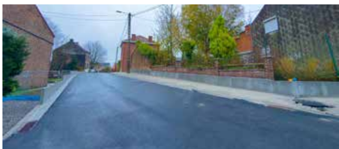
Leval : réfection de la rue de Fontaine
