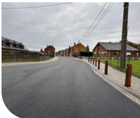
Bray : réfection de la rue de la Chapelette
