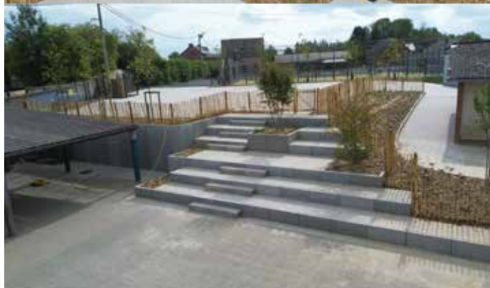
Buvrines : restauration de la cour de l'école de Buvrines
