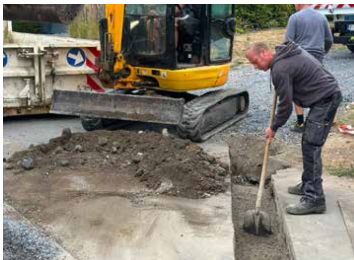
Waudrez : travaux d'égouttage à la rue de Lobbes
