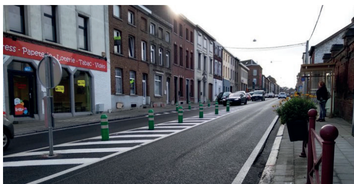
TERMINE / Installation d'un dispositif de ralentissement et de sécurisation des piétons à la rue de Merbes à Binche.
