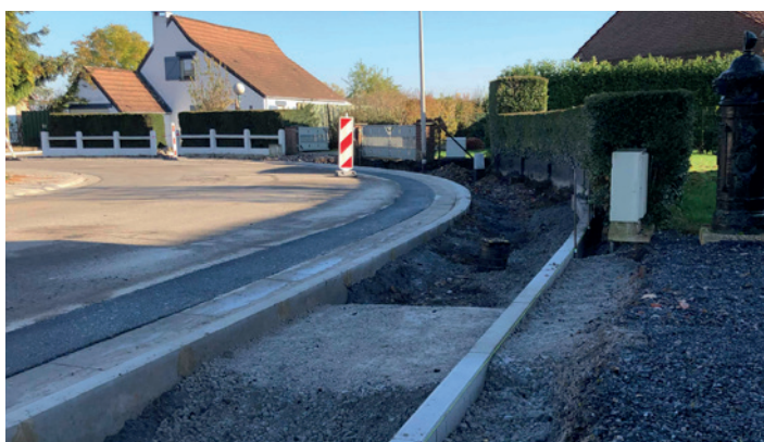
EN COURS / Réfection des trottoirs à la Résidence des Fosses à Bray.
