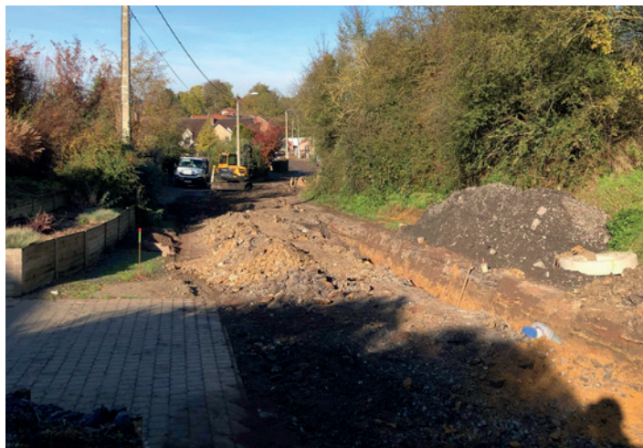
EN COURS / Début du chantier de réfection complète de la voirie à l'avenue Prince Baudouin à Waudrez
