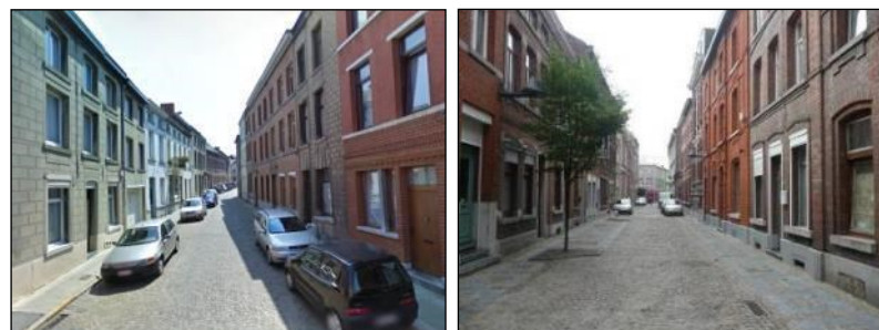
Rue du Cerf et rue Boussart, maisons implantées en ordre continu, R+2+T
