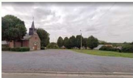
Vue depuis la rue de Namur
